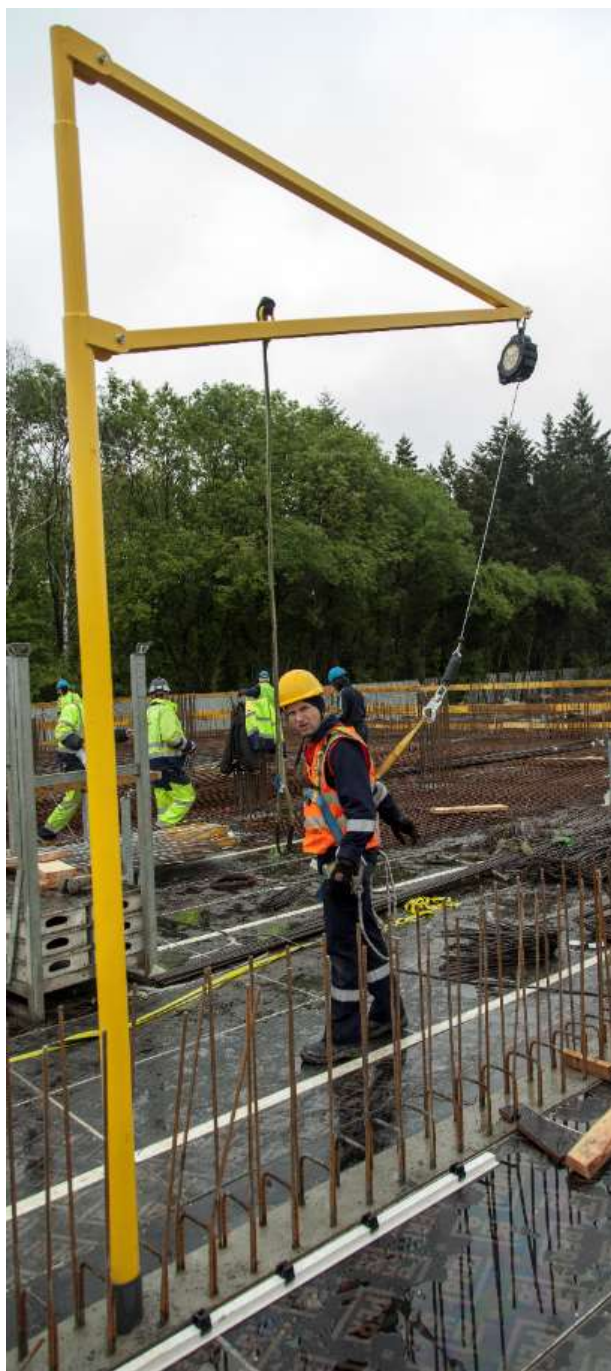
Kompletnie zmontowany zestaw wraz z podpiętym pracownikiem
