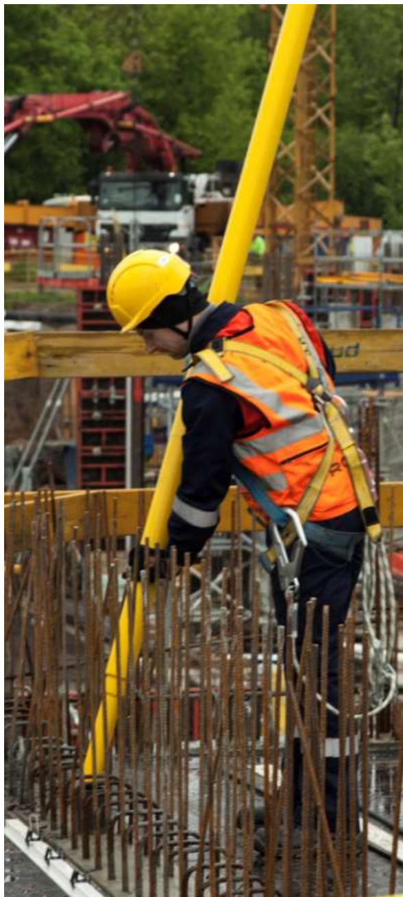
Asysta pracownika przy osadzaniu ramienia w gnieździe
